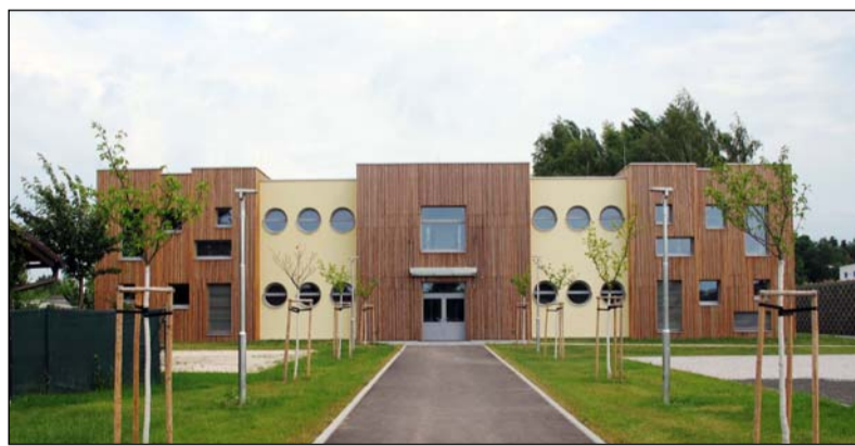
■ Nová mateřská škola Větrov – Ferrari mezi mateřskými školami v Jičíně
